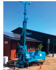
コンパクトな地中熱導入工事
