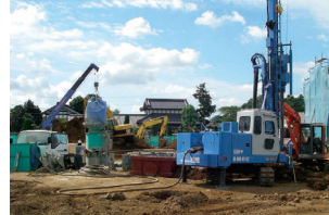
地盤改良工事
