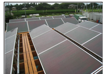
三菱重工製タンデム太陽光発電装置 3.90KW
