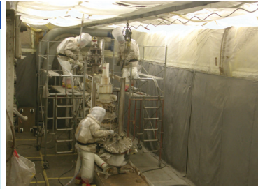
核燃料物質取扱設備の解体撤去工事
