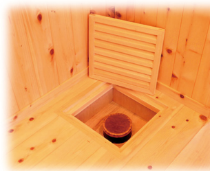
居室内部 地熱吹出し口
