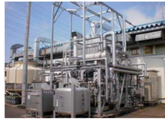
大気を汚さない為の溶剤回収装置
