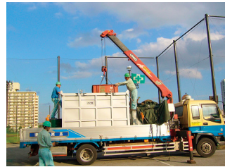
クレーン車を使用して積み降ろし
