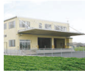
工場・事務所
