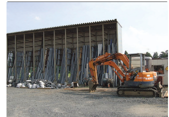
配管倉庫外観
