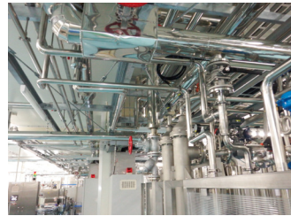
飲料工場内の配管更新工事
