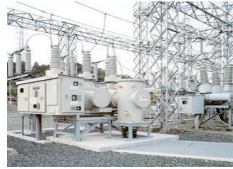
複合形ガス絶縁開閉装置
