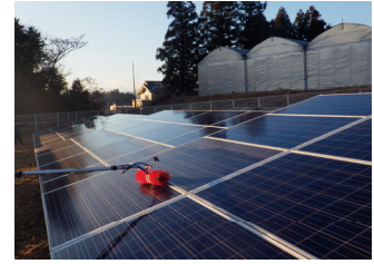
パネル清掃写真
