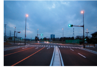
施工例(公共:道路照明設備)
