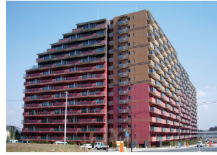
施工例(民間:分譲マンション)
