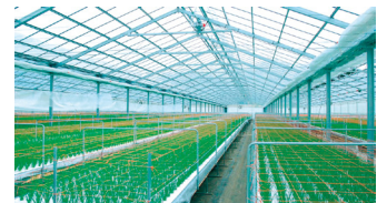
生産設備の設計・施工
