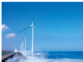
ウインド・パワー かみす第1洋上風力発電
