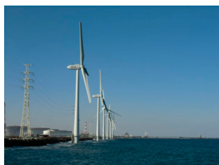
ウインド・パワー かみす第2洋上風力発電
